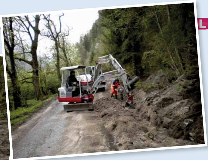
Vorbereitungsarbeiten für die neue Straßenbeleuchtung in der **Arikoglstraße**. Die Stromversorgung erfolgt künftig über ein Erdkabel.
