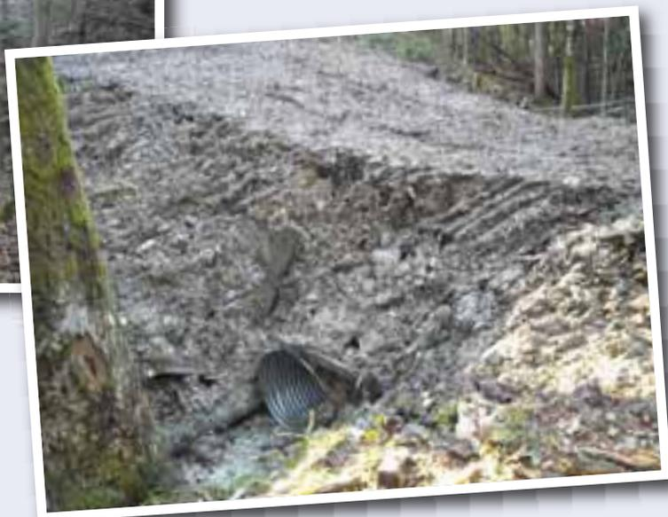
Desolate Brücke im Bereich der „Flohweise“ der Loipe in Pichlern wurde durch Rohrdurchlass ersetzt.
