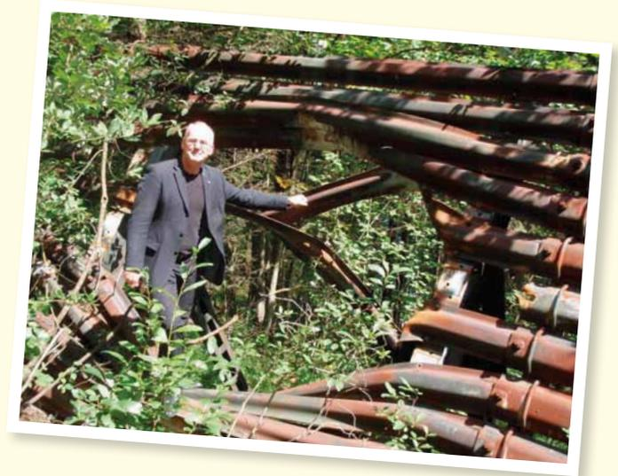
Der zwischen der B 166 und dem Soleleitungsweg errichtete **Steinschlagschutz in Stahlbauweise** zur Sicherung der Bundesstraße wurde von einem Stein durchschlagen und völlig demoliert. In der Zwischenzeit wurden die Schäden im Auftrag der Straßenmeisterei Bad Ischl wieder saniert.
