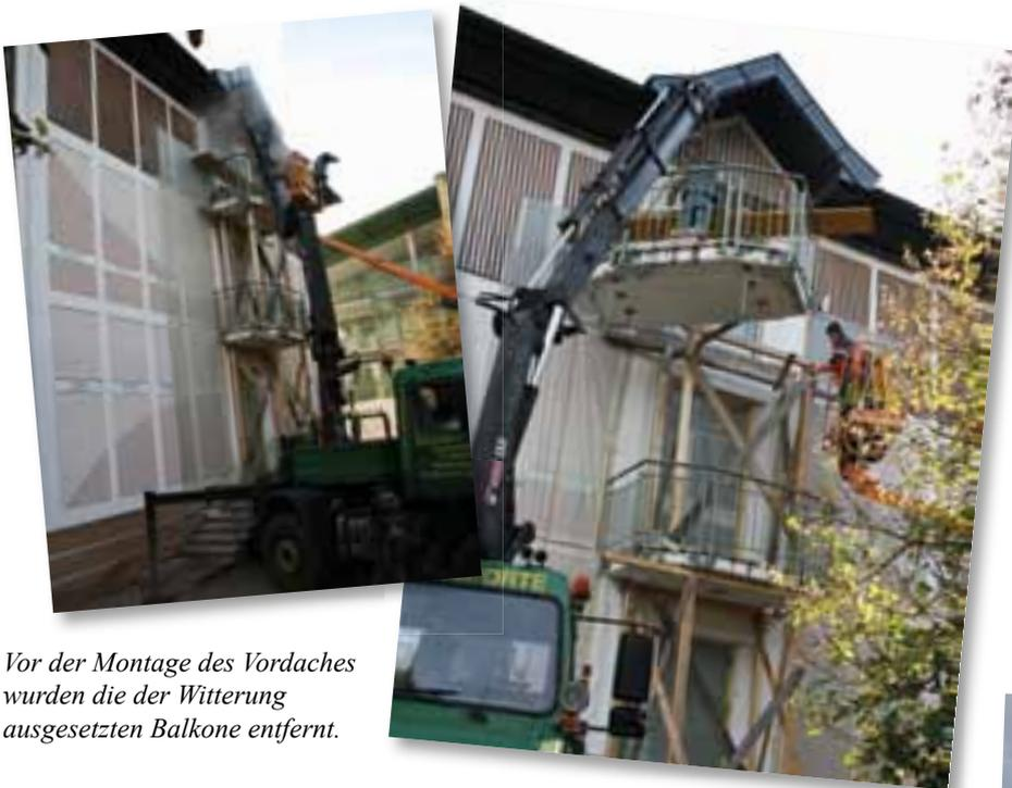
*Vor der Montage des Vordaches wurden die der Witterung ausgesetzten Balkone entfernt.*
