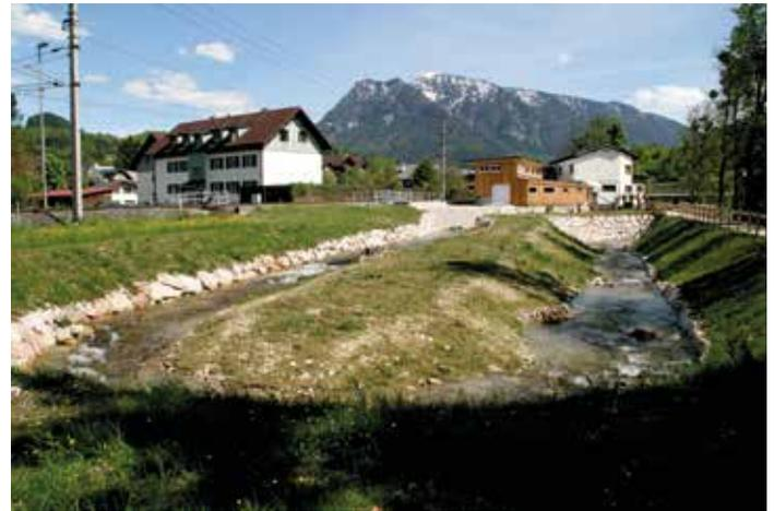
**Die EU-Wasserrichtlinie verpflichtete Bad Goisern zum Bau eines Fischaufstieges bei der Goisererbrücke. Die Gemeinde nutzte die Gelegenheit und schuf mit einem 200 Meter langen naturnahen Bach eine kleine Augenweide. Außerdem wurde der Hochwasserschutz verbessert.**
