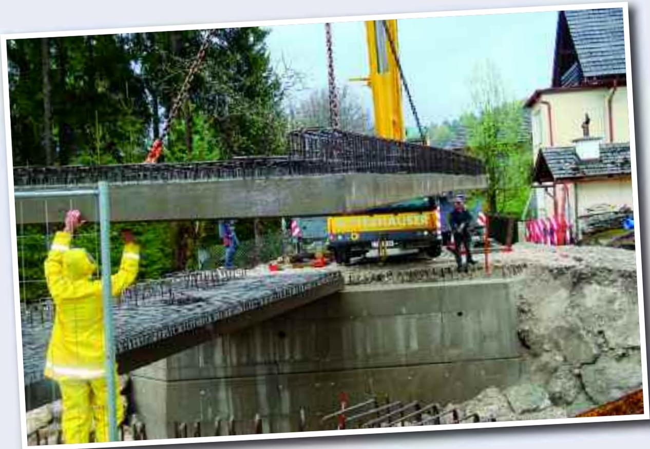
Die von der Firma Kieninger vorgefertigte Fertigteilplatte bei der Verlegung.
