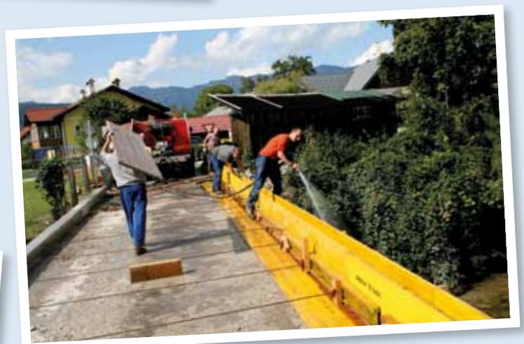
Mit der Zeit kommen auch unsere Brücken in die Jahre. Im heurigen Jahr wurde die sogenannte „Wirtsbrücke“ über den Zlanbach in St. Agatha saniert. So wurden beidseitig die Schrammborde erneuert, eine Feuchtigkeitsabdichtung aufgebracht sowie die Geländer beidseitig ausgetauscht. Abschließend wurde die Fahrbahn der Brücke mit einem Asphaltbelag versehen.
