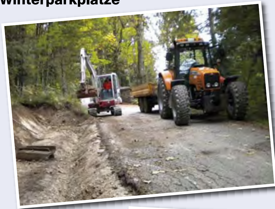
Herstellung von Winterparkplätzen an der alten Pötschenstraße.
