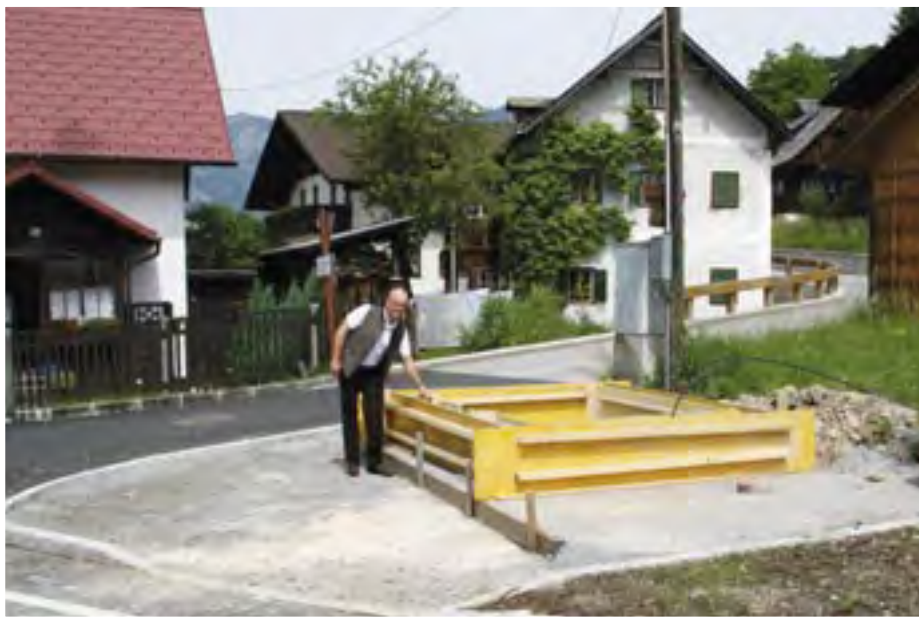
Fundament für die neue „Brunnhütte“ samt Buswartehäuschen für die Kinder in Lasern.
